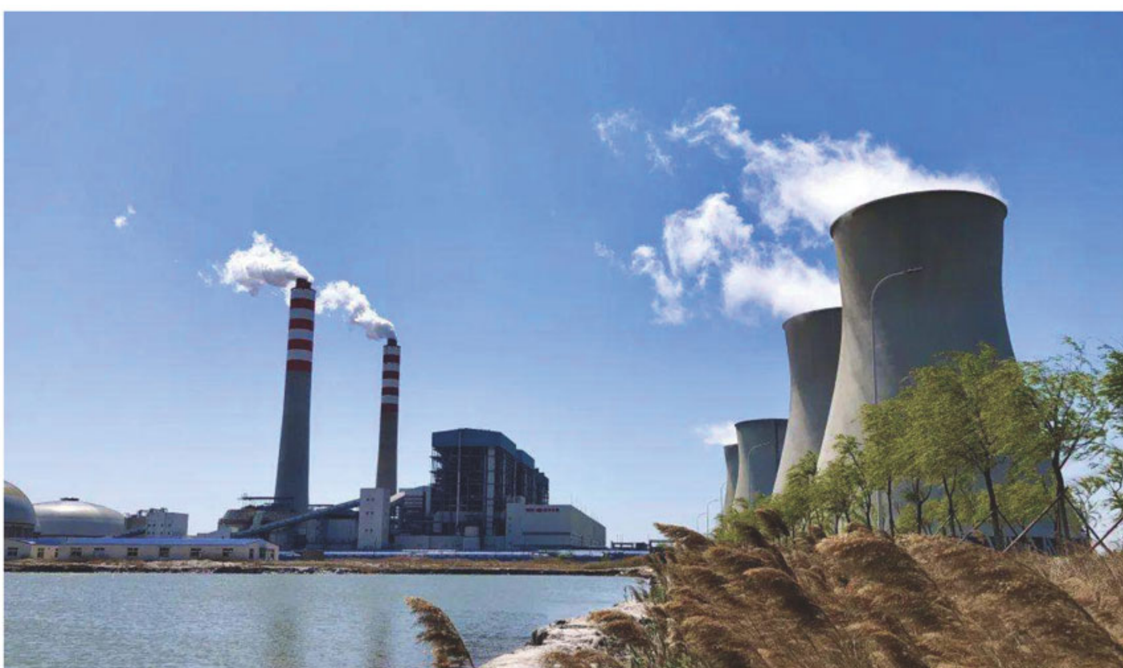
山东临邑恒力热电
