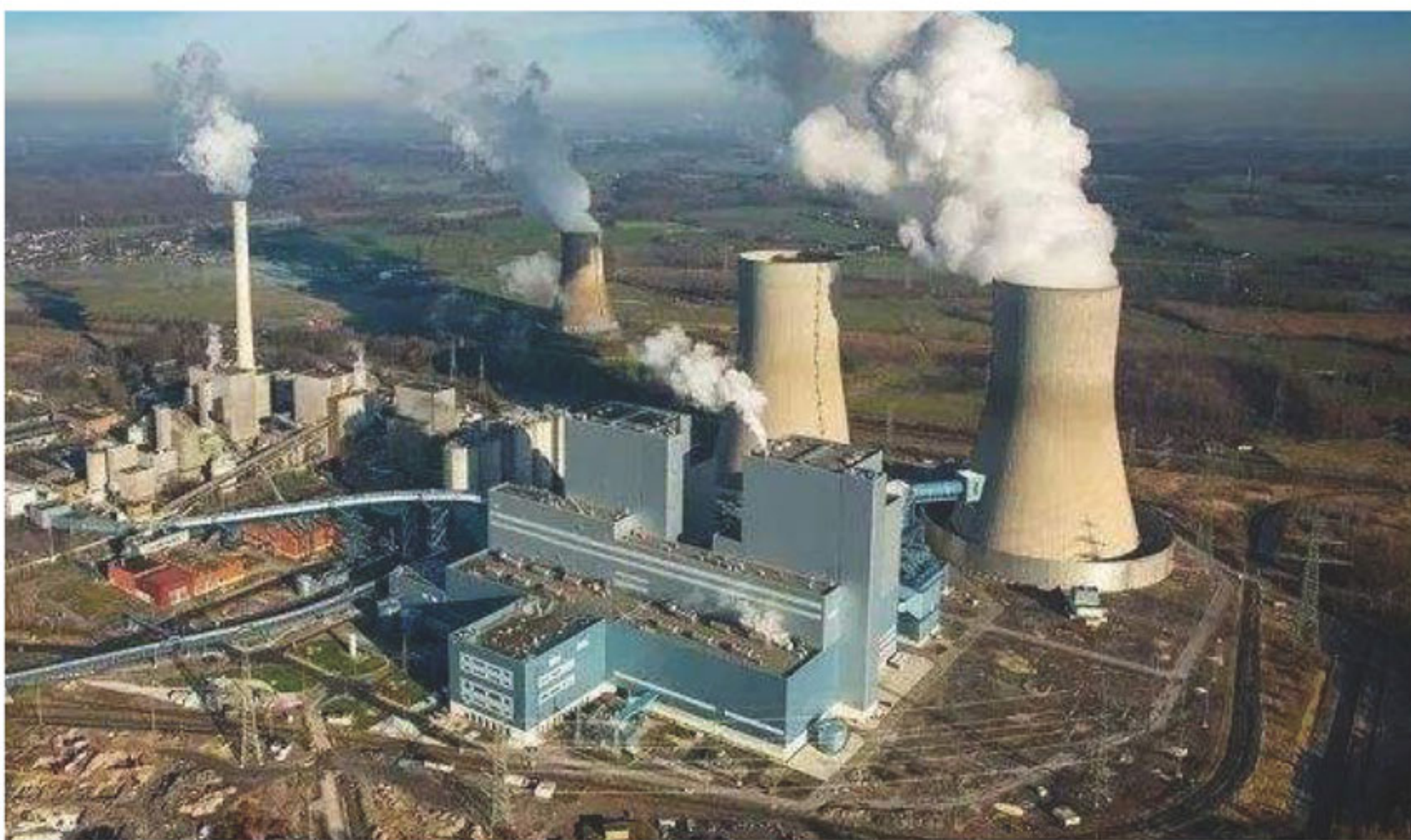
巴基斯坦巴贾姆肖罗煤电站
