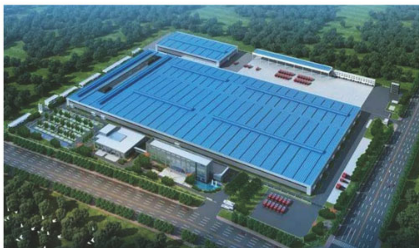
徐工消防车智能制造产业基地联合厂房
